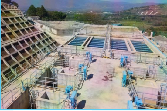
Figura 1. Planta Potabilizadora en Comayagua, Honduras.
